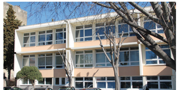
Energetska obnova OŠ Juraj Šižgorić
