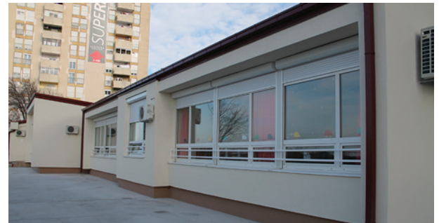
Energetska obnova DV Kućica
